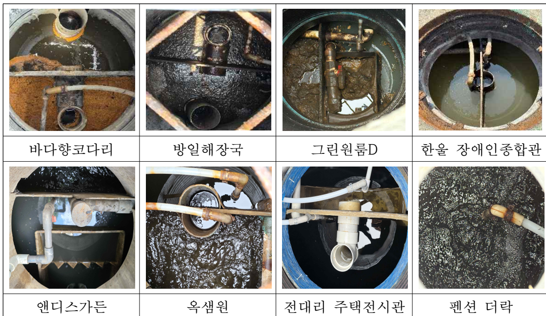
[그림 12] 개인하수처리시설 조사 대상지 모습
